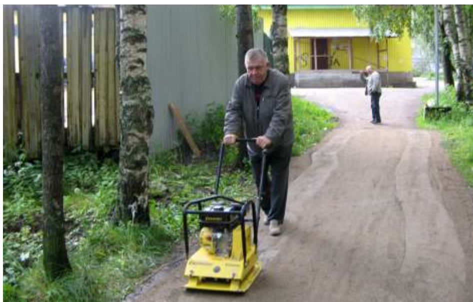
На снимке ведутся подготовительные работы перед укладкой дорожки тротуарной плиткой
